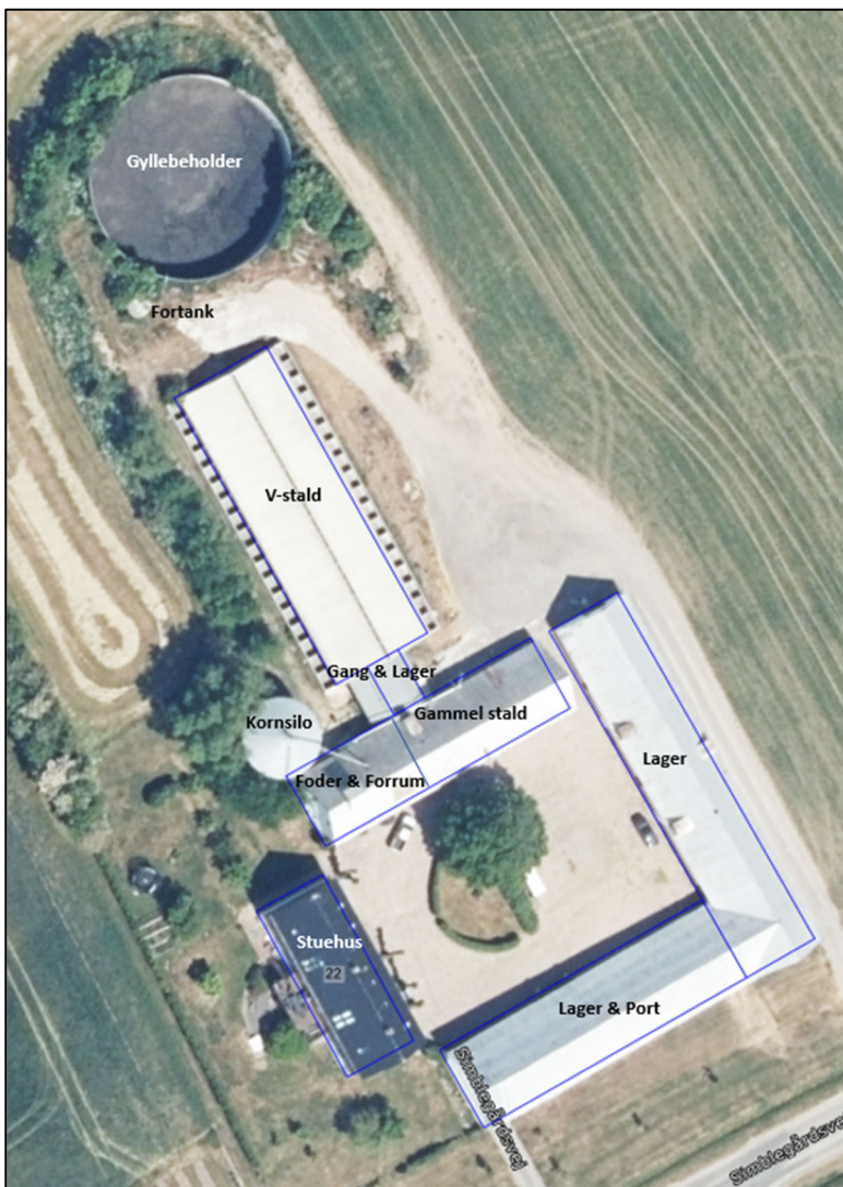
Figur 6 Anlægget på V. Pilegård. Kilde: Ansøgningsmaterialet.
